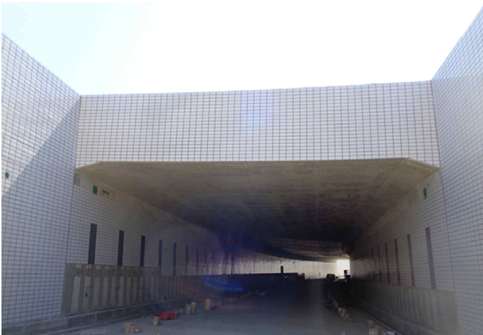
지하차도#1 종점부 내부전경
